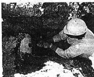
ท่อเหล็กต่อกับแมกนีเซียมหรือสังกะสีป้องกันการผุกร่อนของเหล็กได้
